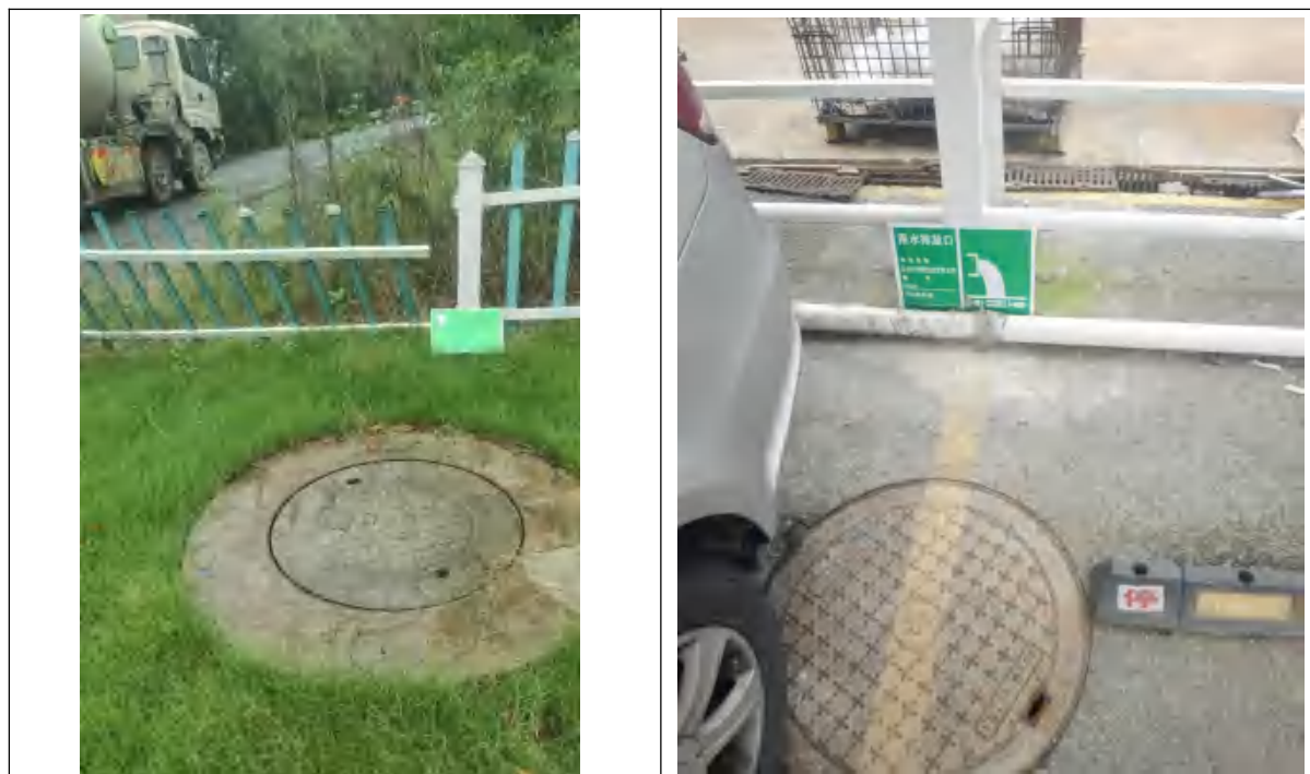
图 3-4 废水排放口情况
