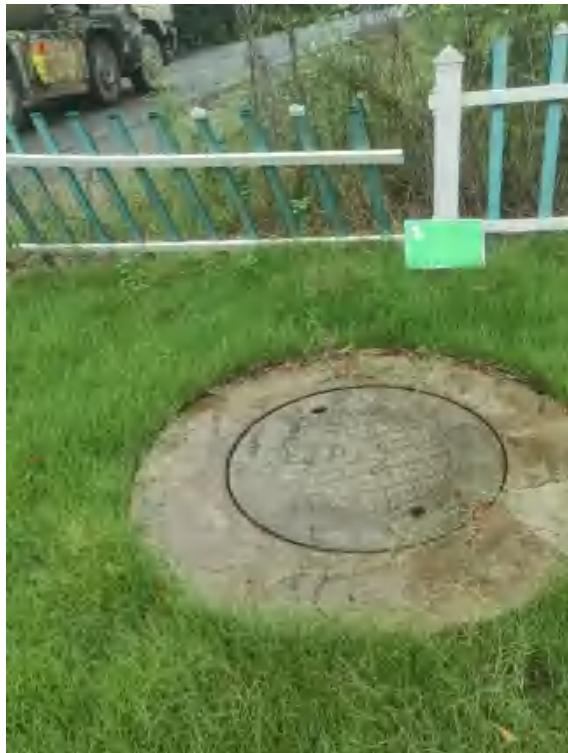
DW001 污水排放口
