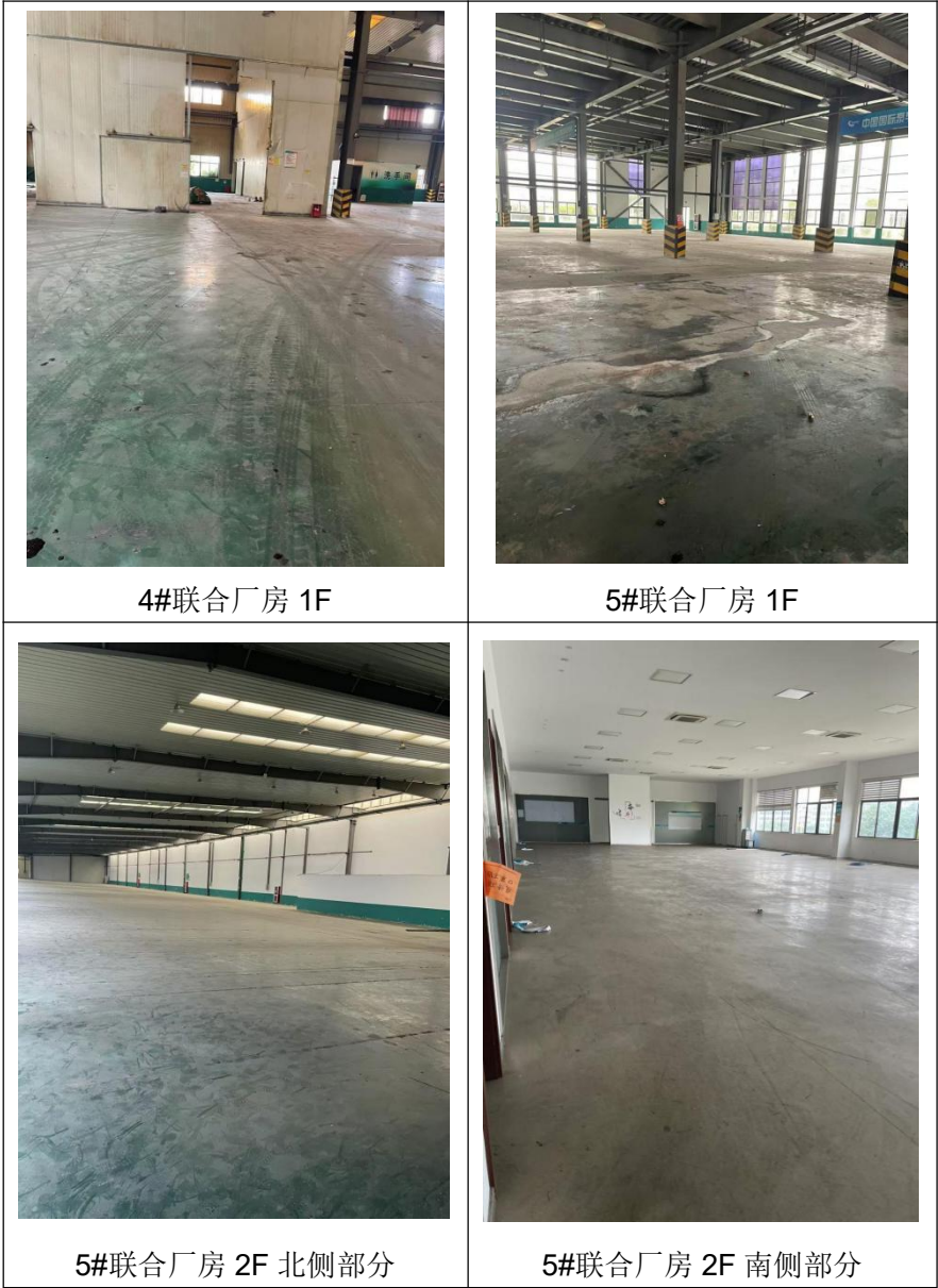
图 2-4 本项目新建厂房照片
