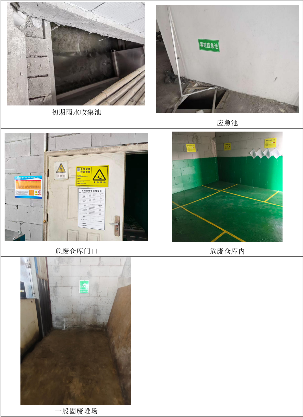
附图 5 项目部分现场照片
