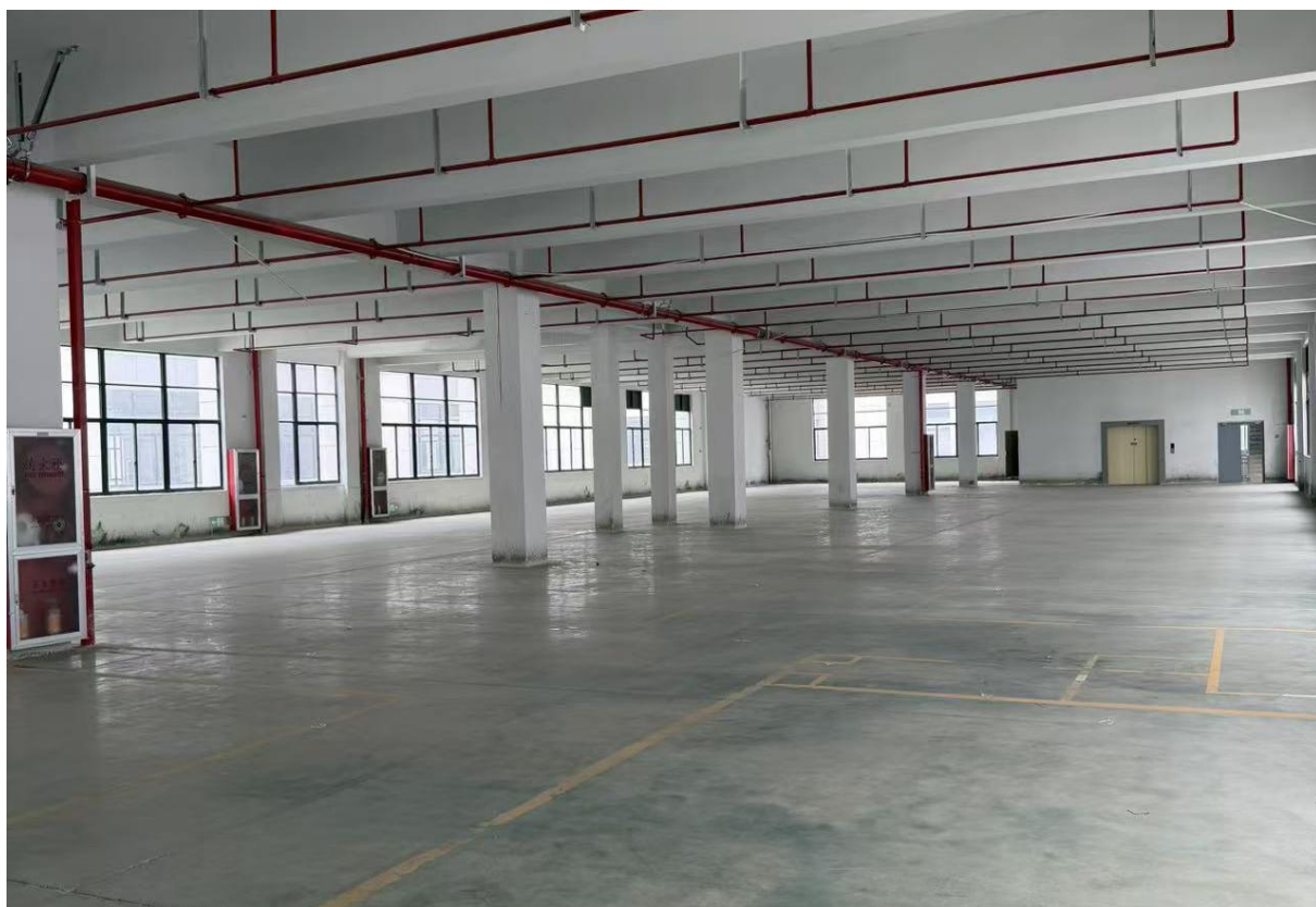
图 2-3 项目厂址照片
